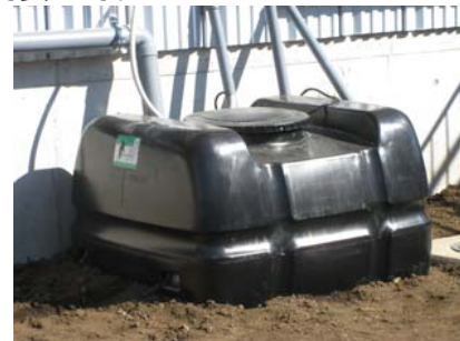
水タンクは設置位置に応じて埋設可能 タンク内に藻が発生しないよう遮光目的の黒色を採用
